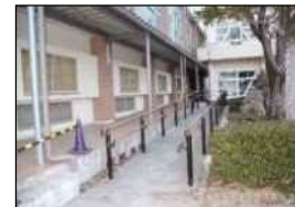
バリアフリー化整備後
