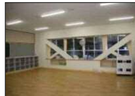
教室棟照明器具LED化整備後
