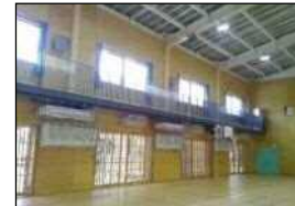
屋内運動場空調設備整備後
