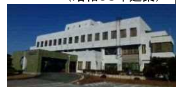
赤羽根市民センター (昭和53年建築)
