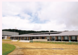
▲学校教育施設(伊良湖岬小学校)
