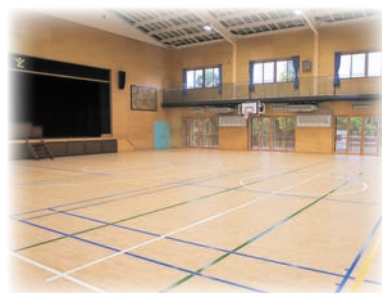
▲ガスヒートポンプエアコン8台が設置された新屋内運動場
