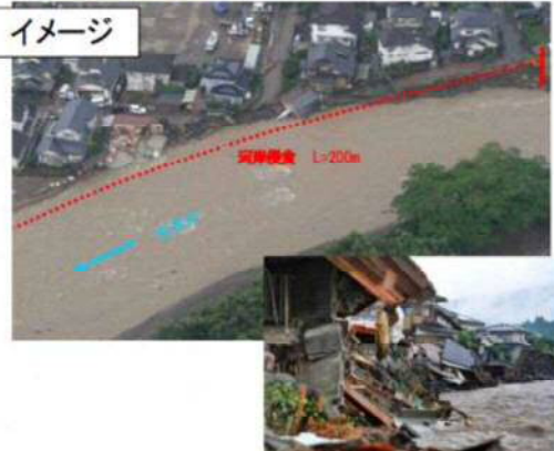
河岸侵食により家屋倒壊した状況
