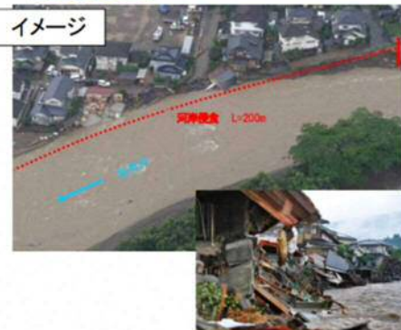
河岸侵食により家屋倒壊した状況
