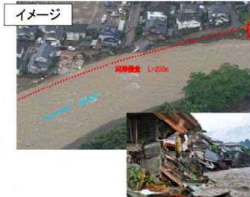
河岸侵食により家屋倒壊した状況
