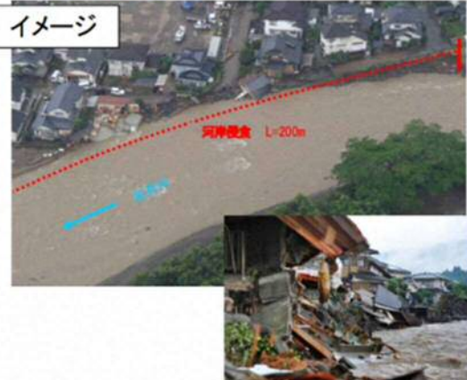
河岸侵食により家屋倒壊した状況
