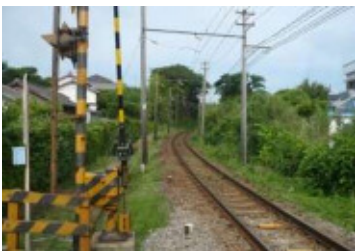
踏切・線路・軌道設備
