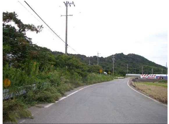
番号 26 県道堀切中山線 (急に道が狭くなりカーブも多く危険)
