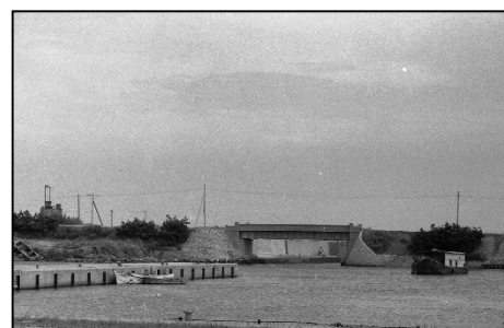
赤羽根漁港：池尻川河口部の旧吹出橋
