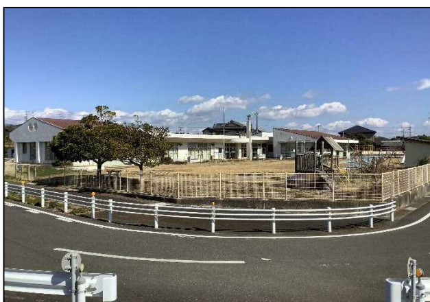
廃園となった若戸保育園
