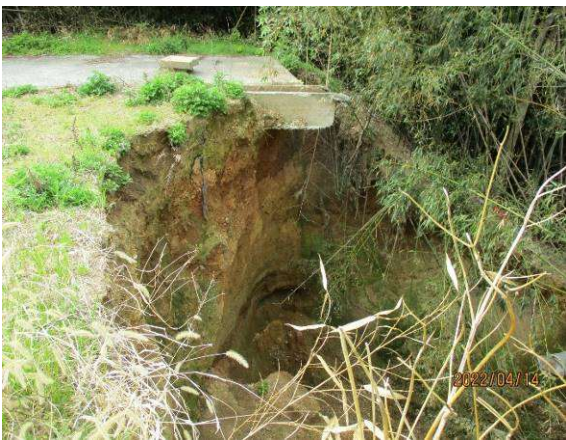
危③ 土砂崩れの改善
