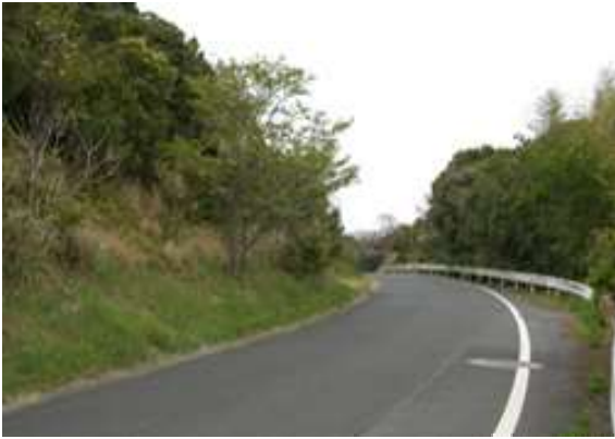
環⑨ 尾村崎線桜並木の整備
