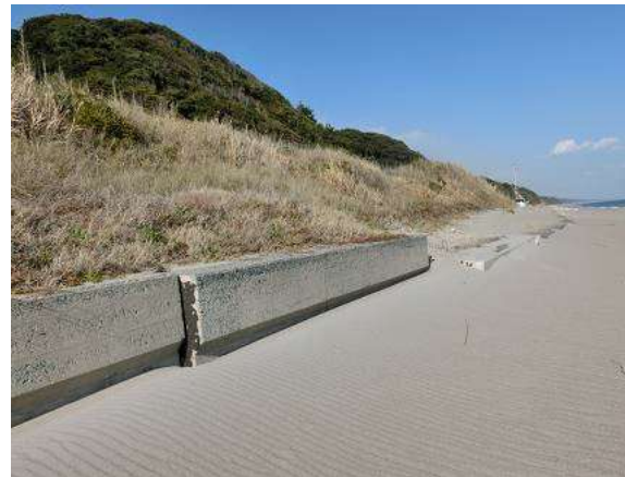
危⑥ 海岸防波堤の破損箇所修理
