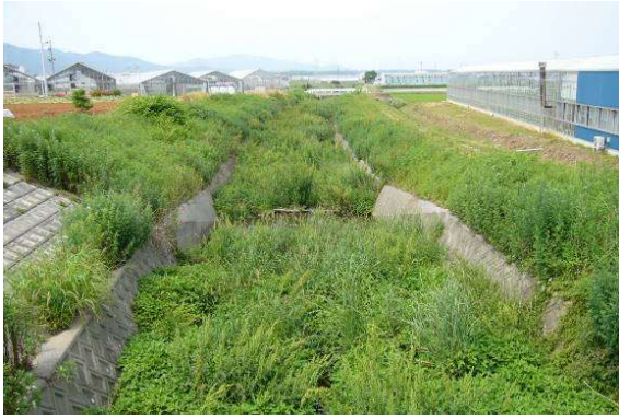
環① 大日川法面草刈り、浚渫
