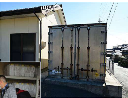
一色防災倉庫
