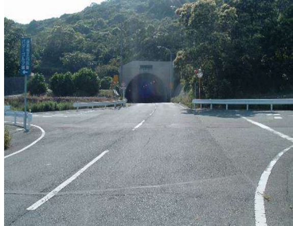
危② トンネル出口、標識見直し
