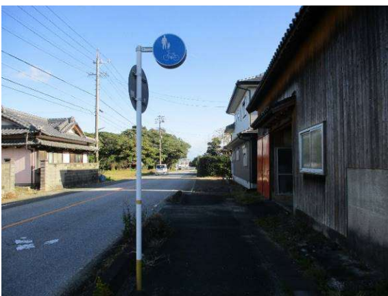
危⑤ 歩道未開通箇所整備、道路照明灯設置
