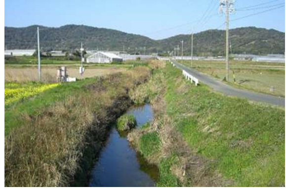
環② 尾村崎川法面草刈り、浚渫
