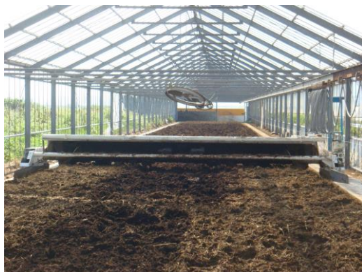
農地還元施設(攪拌式乾燥ハウス)
