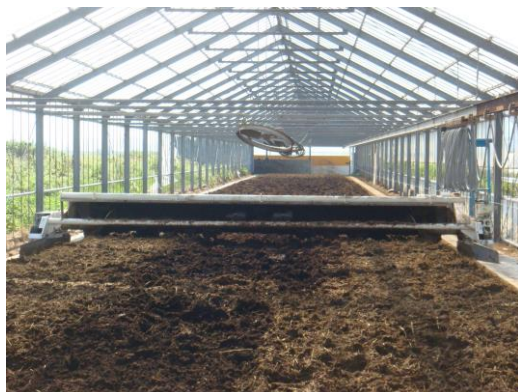
農地還元施設(攪拌式乾燥ハウス)
