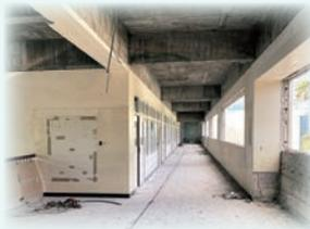
福江小学校では一度、建物を骨格部分だけを残してスケルトン状態にし、ひび割れなどの劣化部分を補修し、内装や外壁などを改修しました。
