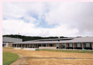
▲学校教育施設(伊良湖岬小学校)
