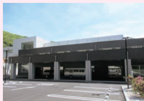
▲衛生施設(田原斎場)
