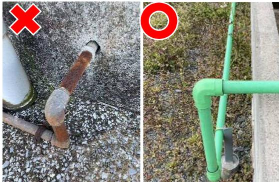
地面や防油堤に接して配管を敷設すると、地震等により損傷する恐れがあります。
