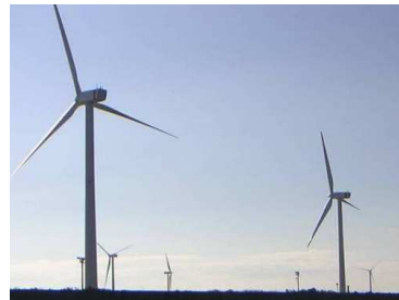
▲田原臨海風力発電所
