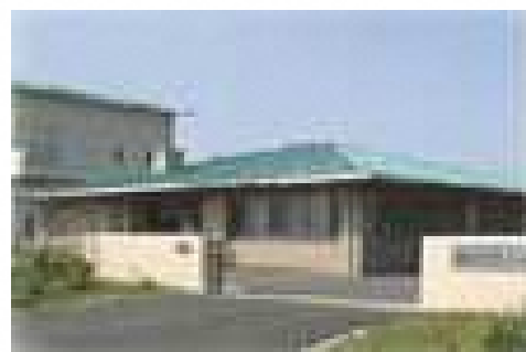
渥美浄化センター
