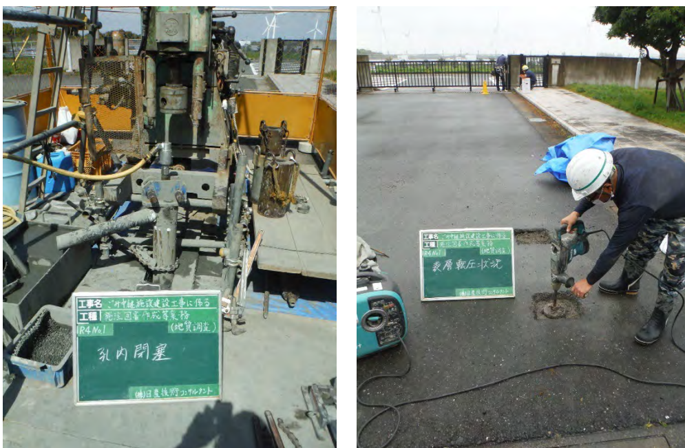
図2.2.3 調査孔閉塞状況と表層転圧状況
