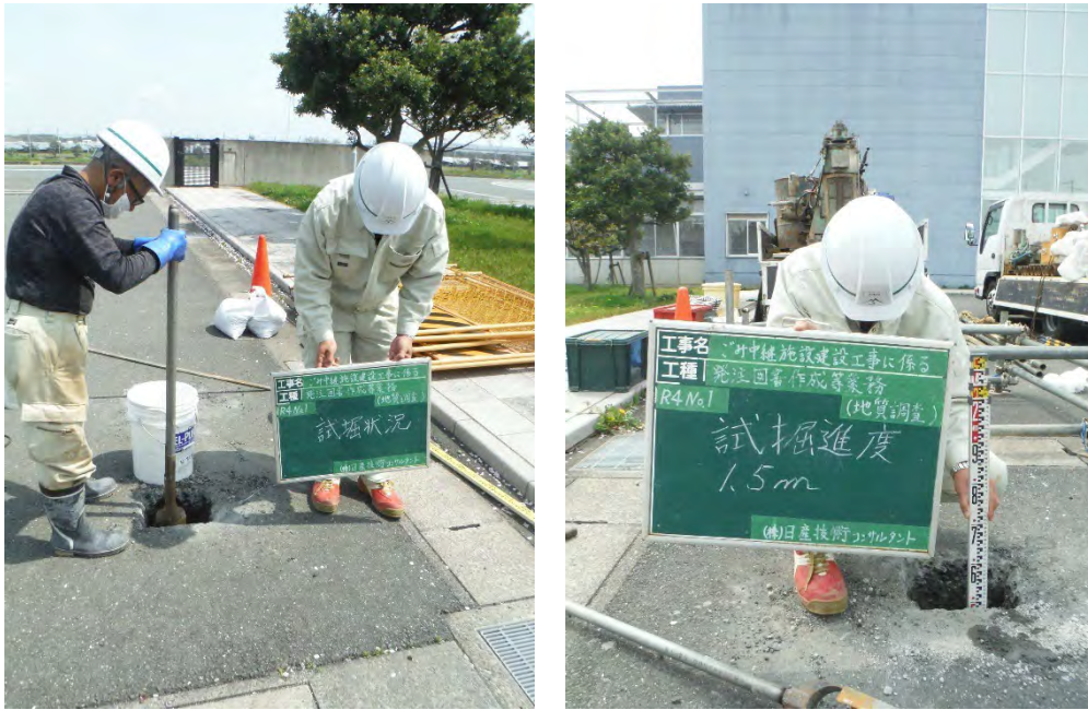
図2.2.2 既存埋設物破損防止を目的とした人力による試掘状況
