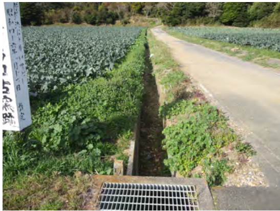
図 95 大アラコ古窯跡 排水用U字溝の状況
