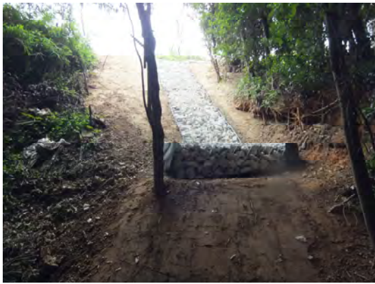
図 93 百々陶器窯跡 フトン籠設置時の状況
