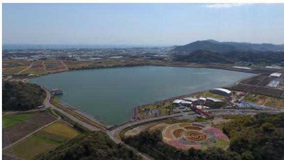
図 97 芦ヶ池調整池 独立行政法人水資源機構提供
