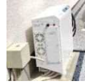
V2H(電気自動車充電設備)
