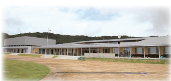
▶完成した新校舎と体育館
