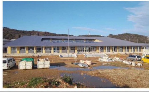
●伊良湖岬小学校校舎棟現況写真
