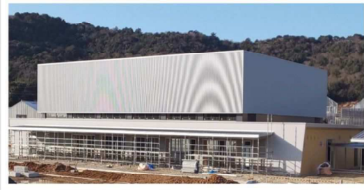
●伊良湖岬小学校体育館棟現況写真
