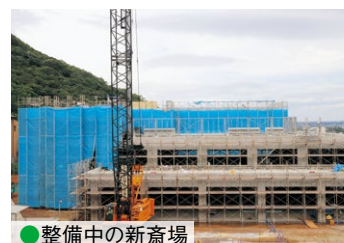
●整備中の新斎場
