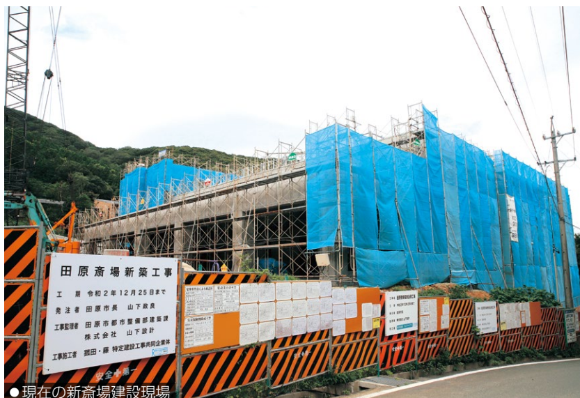
●現在の新斎場建設現場
