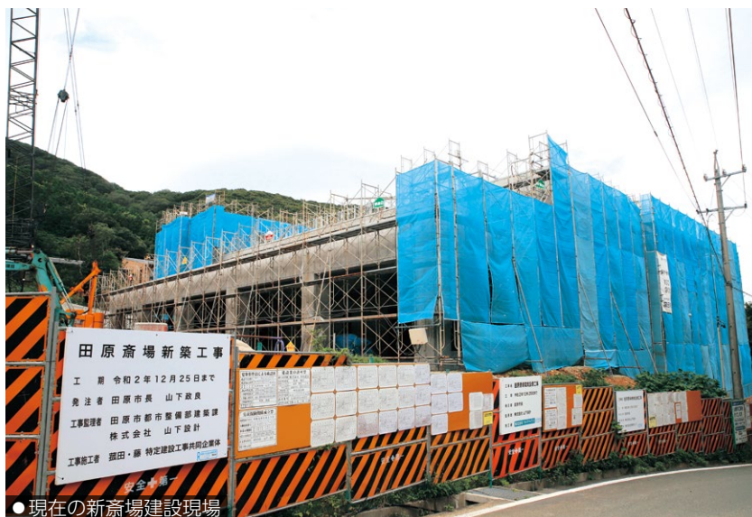
●現在の新斎場建設現場
