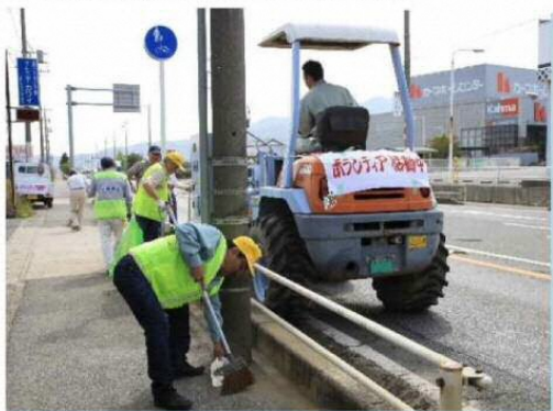
■地域による沿道の土砂撤去作業
