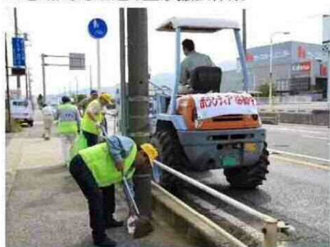
■ 地域による沿道の土砂撤去作業
