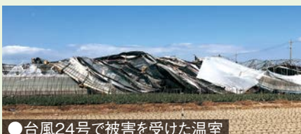
●台風24号で被害を受けた温室
