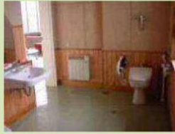
多目的トイレの設置 秋田県男鹿市立北陽小学校
