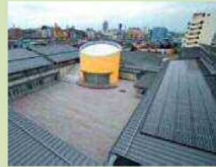
屋根に太陽光パネルを設置 東京都多摩市立多摩第一小学校
