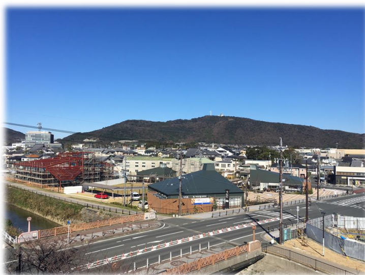
田原市街地(ラグラン内で建設が進む『親子交流施設』)
