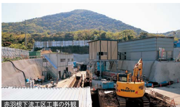
赤羽根下流工区工事の外観
