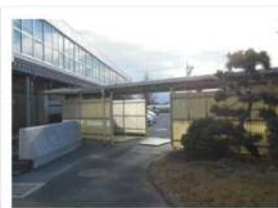
▲⑨:体育館連絡通路
