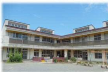
解体撤去する 山北保育園
