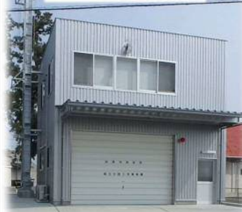
【消防団詰所・車庫】
