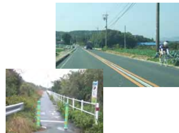
自転車道の安全性の欠如、未整備
