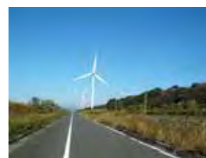
臨海工業地帯の風力発電施設
