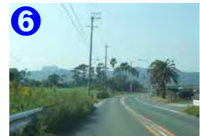
南国ムードの演出として高木のヤシ等が植栽されているが、電柱と混在してその特長を活かしきれていない。
