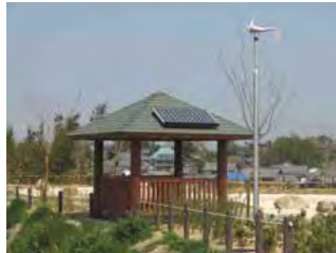
太陽光発電や風力発電を活用する公園施設（東部里山公園）
