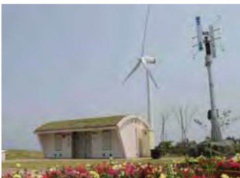
環境共生技術のトイレと風力発電（エコパーク）
