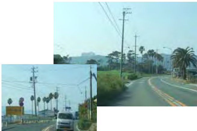
電柱類、沿道の雑草、荒地等による景観の阻害
