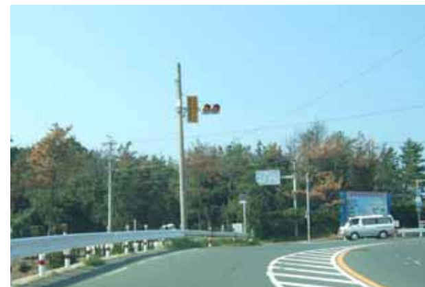
枯松や道路付属物による景観の阻害
