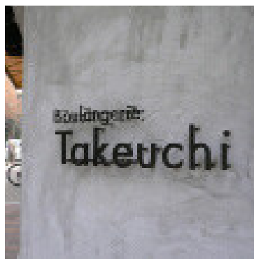
▲コンクリートの外壁に打ち付けられた鋼材の切り文字が、お洒落な印象を与えています。(大阪市)
