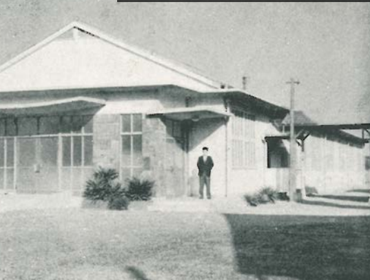
●昭和31年5月竣工の渥美伝染病院（田原町築出地内）
