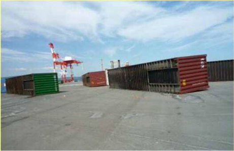
神野西8号岸壁コンテナターミナル
