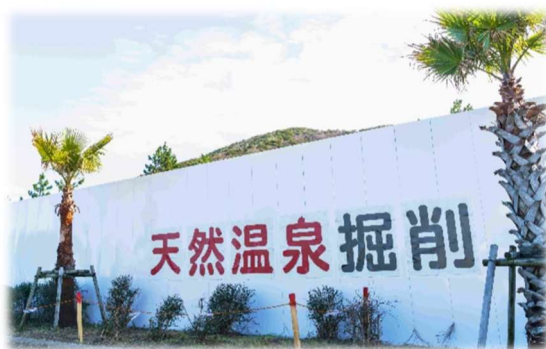
温泉掘削工事の様子（伊良湖地区）
