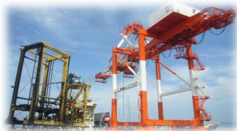
三河港（コンテナターミナル）
