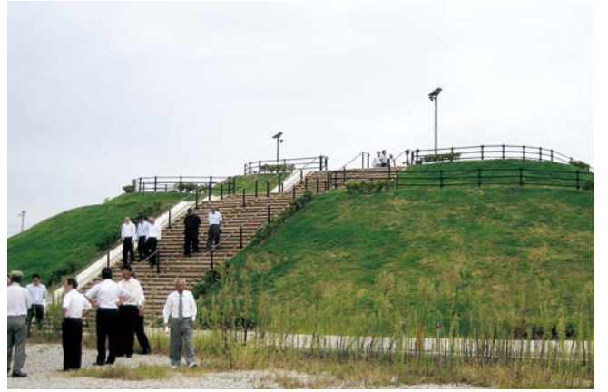
▲静岡県袋井市にある津波避難施設「湊命山」を視察
