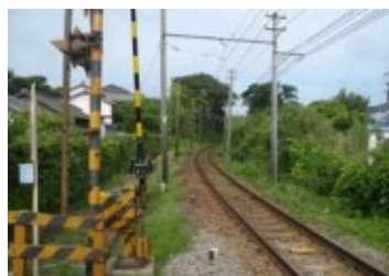
踏切・線路・軌道設備
