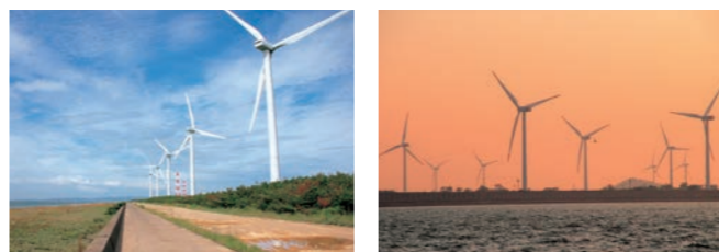
渥美風力発電所(小中山地内) 1500kW×7基 田原臨海風力発電所(緑が浜地内) 2000kW×11基、1980kW×1基
