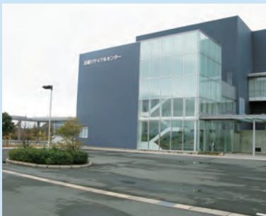
PFI方式によるゴミ処理施設「炭生館」運営は特別目的会社であるグリーンサイトジャパン(株)が行っている。
