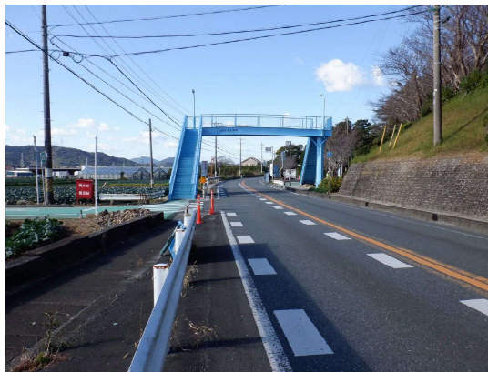
<大久保歩道橋>
