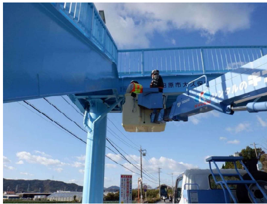
＜大久保歩道橋＞
