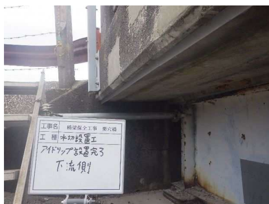
写真2. 水切りアイドリップ設置状況（栗穴橋）
