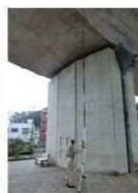
高所型を用いた点検
