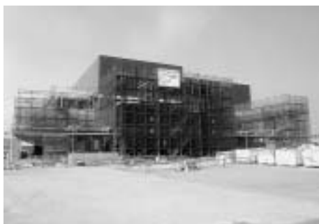
建設が進む田原リサイクルセンター
