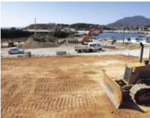
工事が始まった道の駅「赤羽根」
