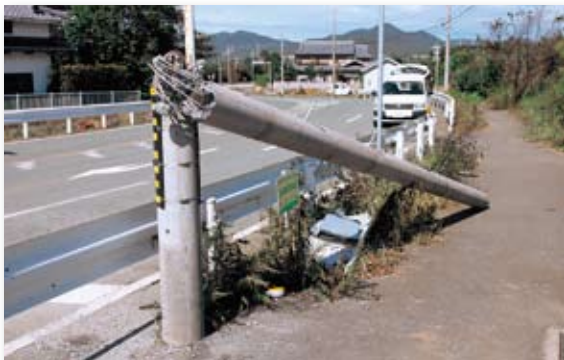
▲飛散物が当たって折れた信号機の支柱（赤羽根町）
