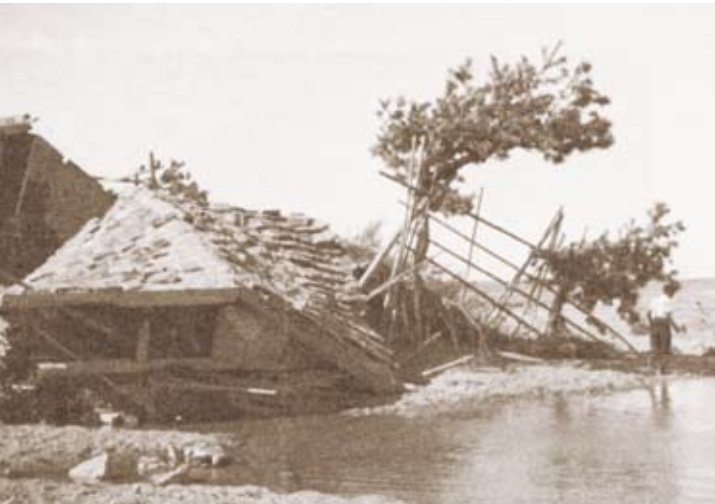
▲倒壊した海岸沿いの家屋（昭和34年・向山町）
